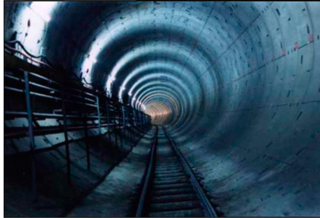
2. sz. kép: Mélyvezetésű beton – túbbinges technológiával épült alagútrészlet 4
