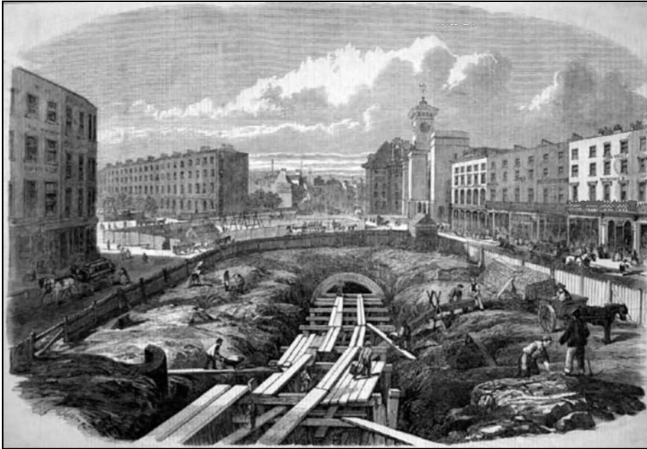
4. sz. kép: „Cut and cover” technológiával épül a londoni metró 8
