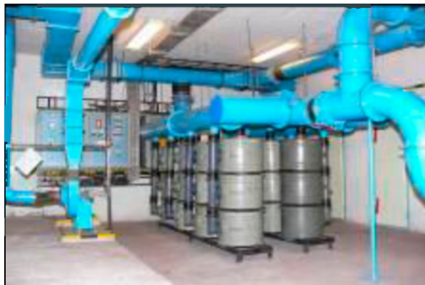
6. sz. kép: A WC-csoport szellőzőrendszere a bűzszűrőkkel 8
