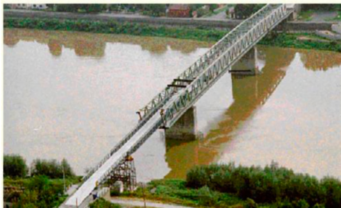
2. számú kép – Mabey & Johnson híd Bosanska Gradiskánál (Horvát – Szerb határátkelőhely a Száván) 6
