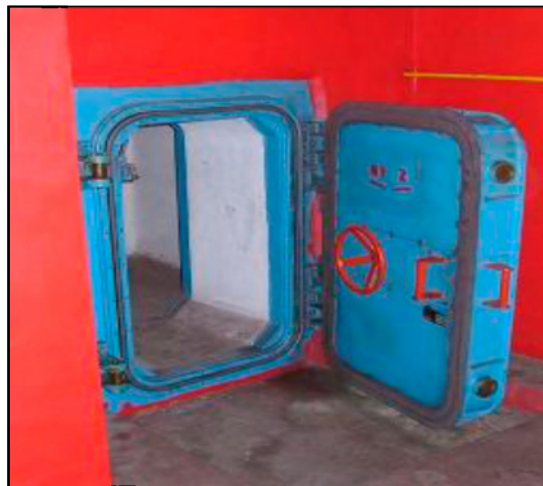
5. sz. kép: Expanziós tér, kézi működtetésű ajtóval 7
