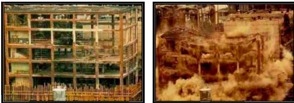
1. kép: Épületrobbantás a Peremartoni Vegyigár területén 3
