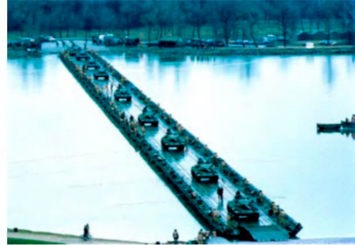
5. sz. kép PFM híd 8
