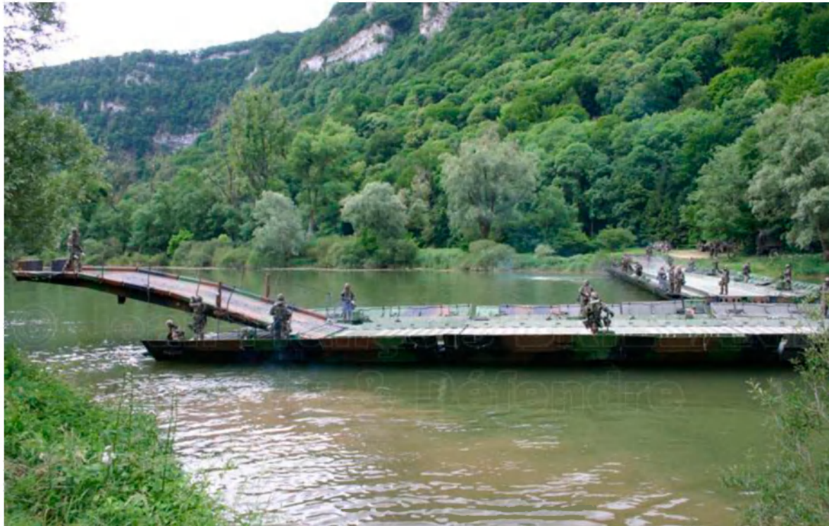
17. sz. kép Hídépítés „befordítással” 29
