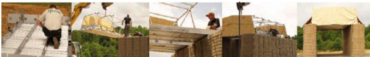
15. sz. kép A HESCO könnyűsúlyú óvóhely tetőszerkezet beépítése 26
