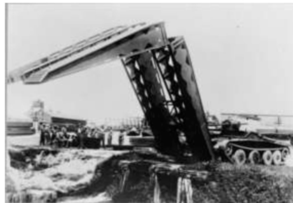
3. sz. kép Ollós hídszerkezet 8
