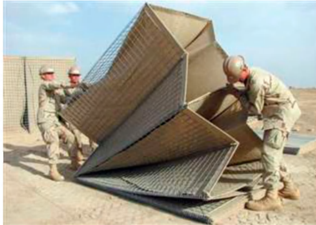
8. kép. HESCO bástyák építéséhez gabion hálót állítanak Afganisztánban 6
