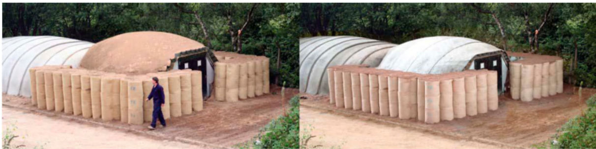
4. ábra: Alagút formájú sátor földborítással és plusz vászonnal erősítve
