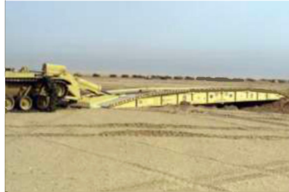
6. sz. kép A híd telepítése 13
