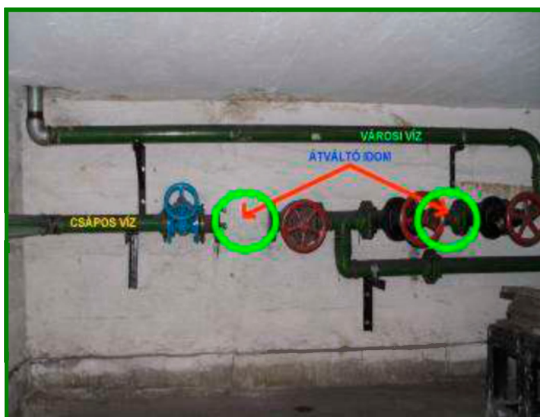
3. sz. kép: A metró kettős vízellátó rendszere. 7
