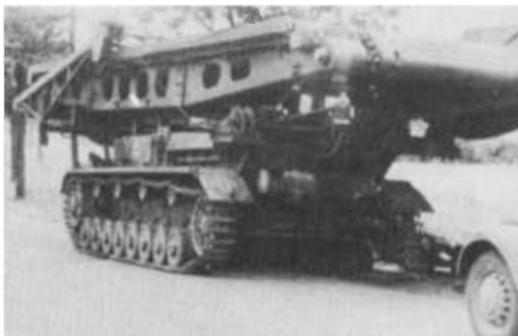
2. sz. kép Kitolható hídszerkezet 7
