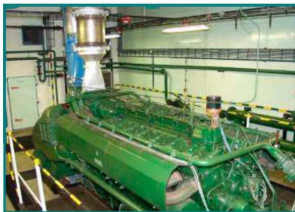
2. sz. kép: A metró energiaellátást biztosító 2X8 hengeres dízel gép. 6
