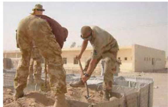
9.-10. kép. A fémhálós keretek földdel való megtöltése történhet gépi vagy kézi erővel
