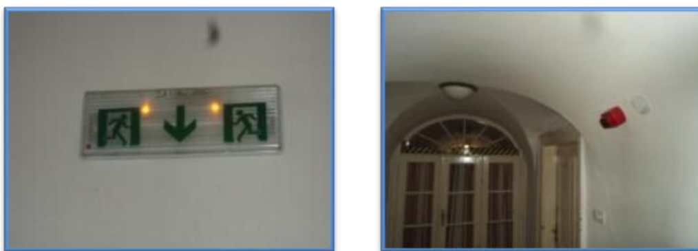
6 – 7. kép: menekülési útvonalat jelző és riasztási fényjelző berendezések
