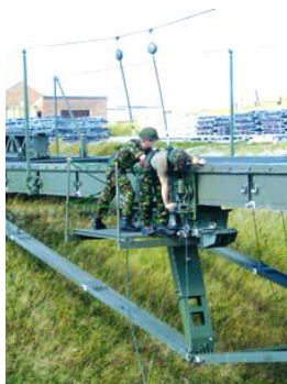
30. sz. kép A kapcsolaterősítő szerelék feszítése 54
