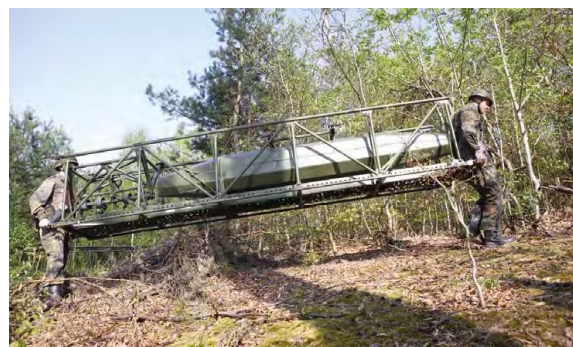
5. sz. kép A hídelemek kézi szállítása 15
