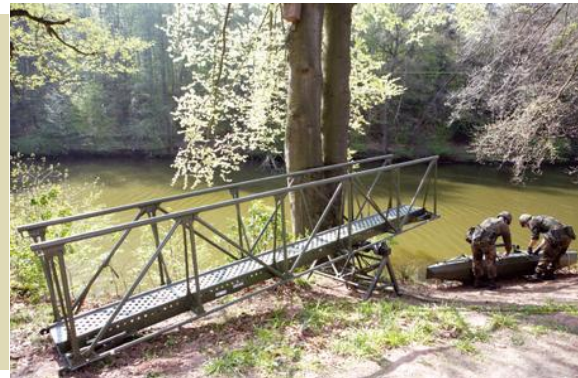
6. sz. kép Modul hídelem a támasztógörgővel és az úszóaljzat előkészítésével 17
