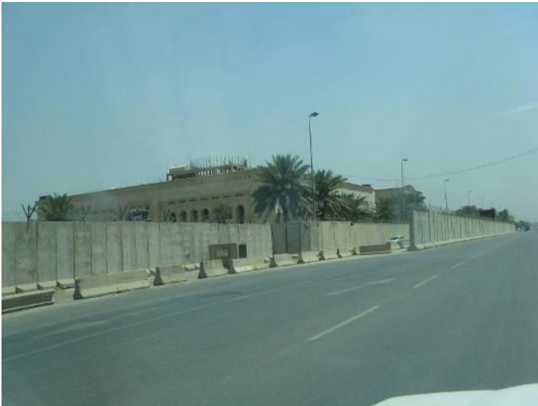
2. sz. kép: A táborba behajtó forgalom elkülönítése a városi forgalomtól „T falak” alkalmazásával
