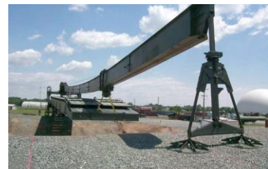
4. sz. kép A telepítő gerenda építése, túlpárti talpalása 21
