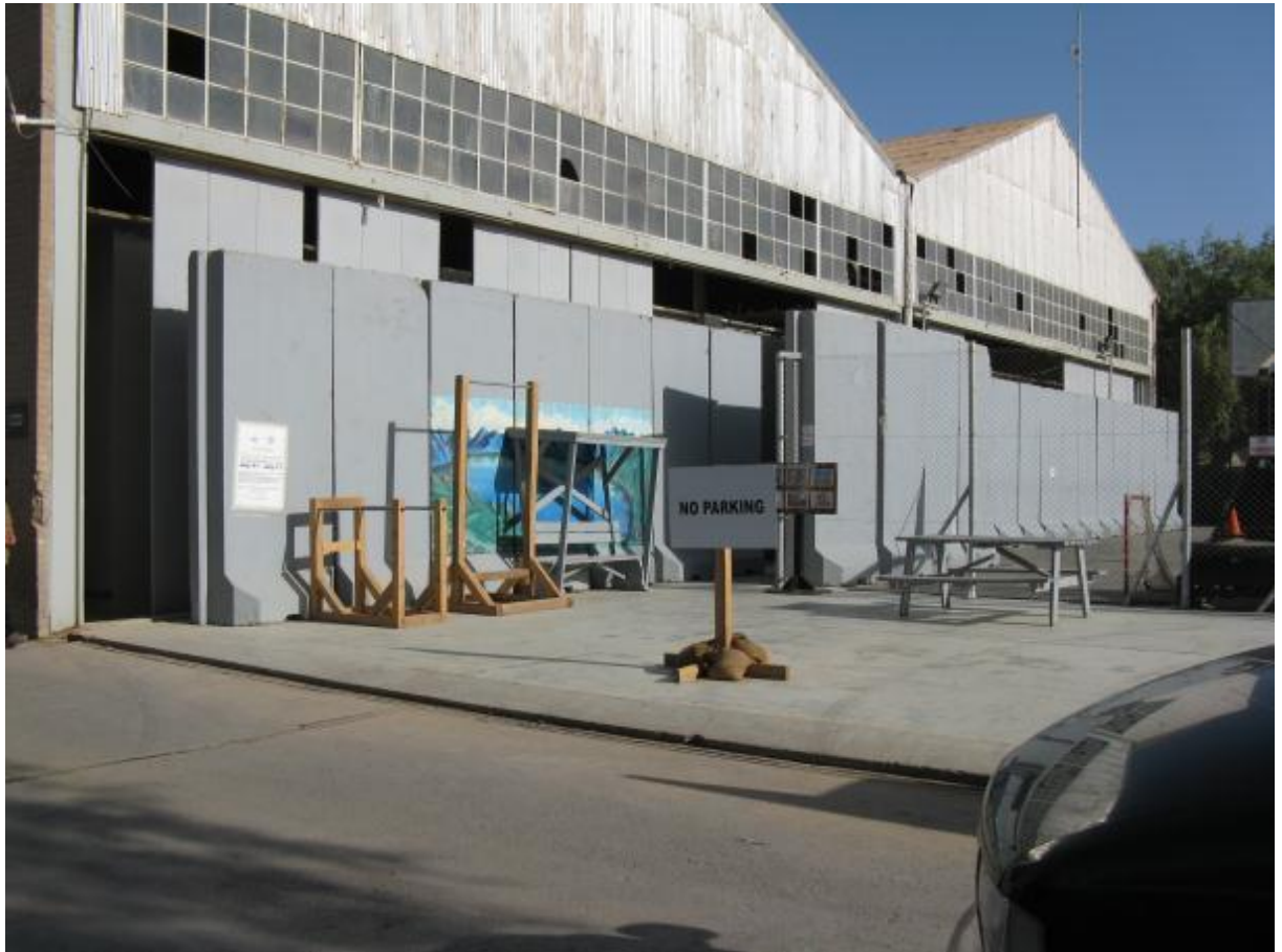
5. sz. kép: Edzőterem bejáratának védelme sakkáblaszerűen elhelyezett „T fal” elemekkel
