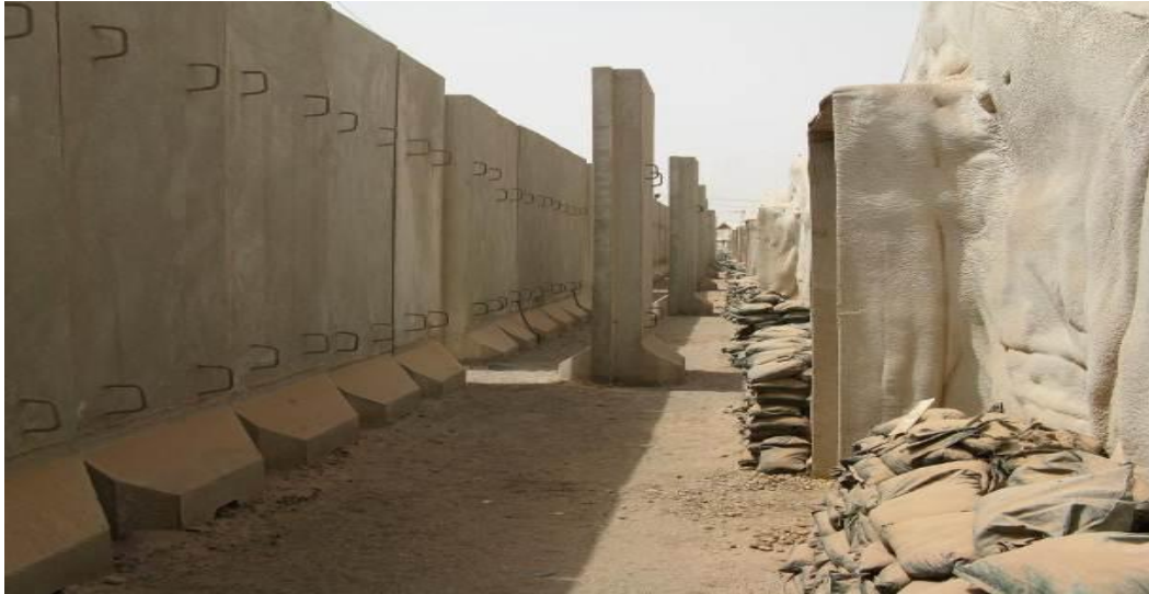
7. sz. kép: Sátorosorok végeinek lezárása „T falakkal”
