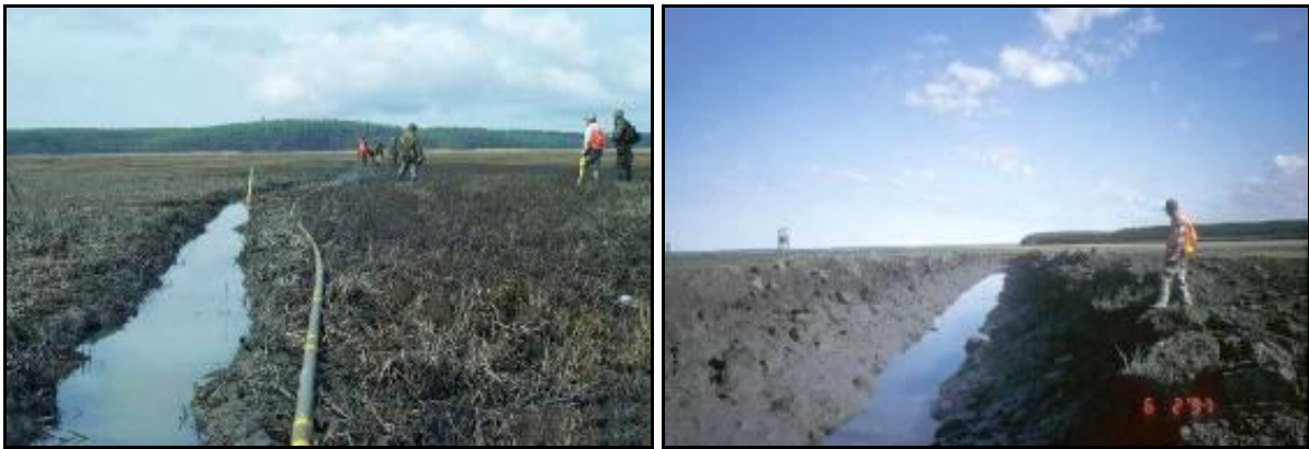
7. kép Csatorna szélesítése, mélyítése tömlős töltettel 18
