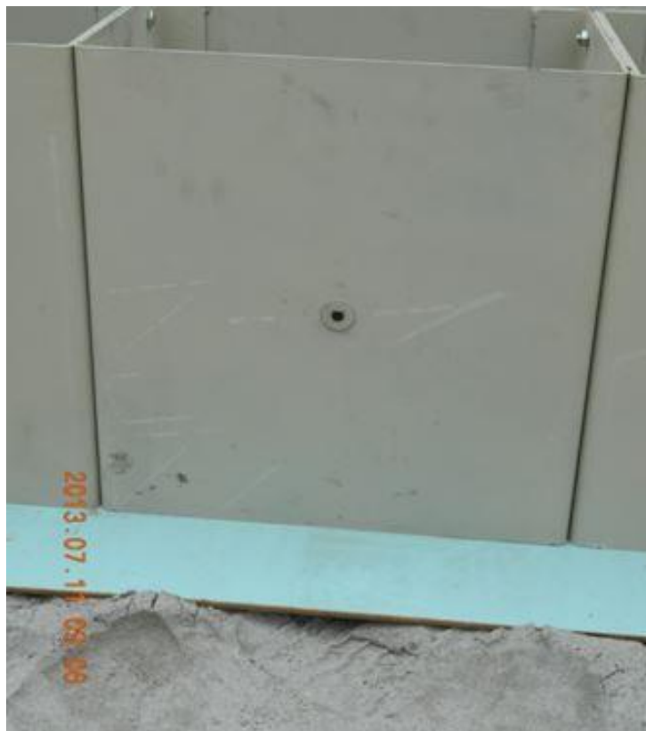
3. sz. ábra: A falba épített 134A22 típusú, tourmalin nyomásmérő reflexiós szenzor
