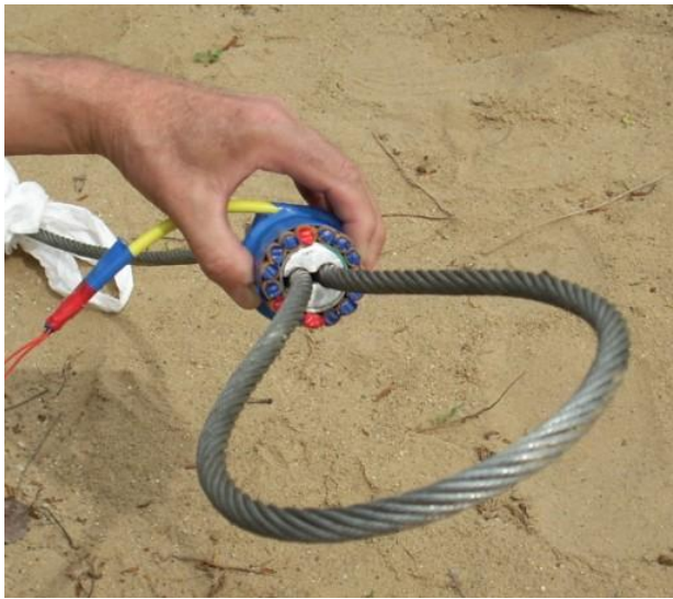
7. sz. ábra: Ø12 mm-es acélsodrony kötél szerelése elektromos illesztő-betéttel, illetve kiegészítő alumínium rudakkal 15
