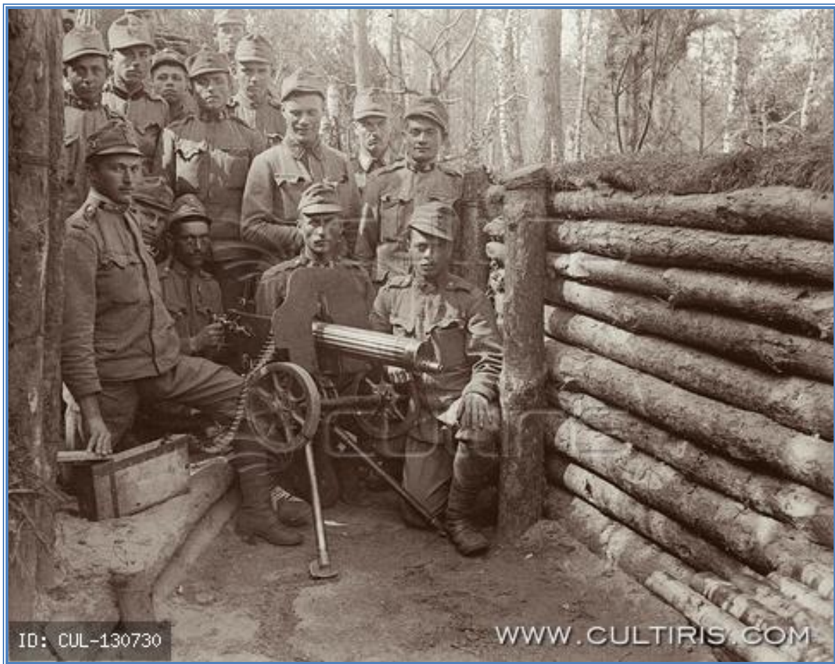
Lövészárók fa megerősítéssel 3
