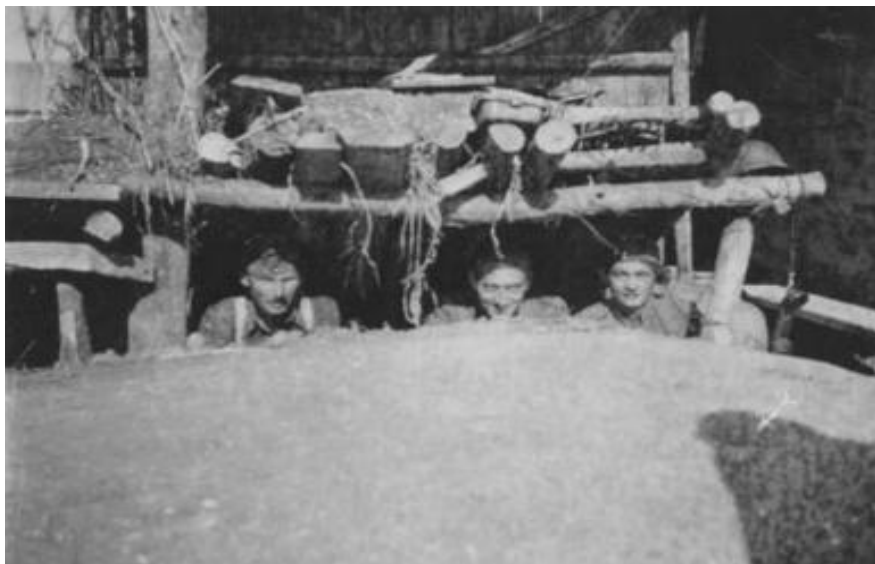
„Földbe mélyített rejtékállás, jobb végében a telefonnal” 36
