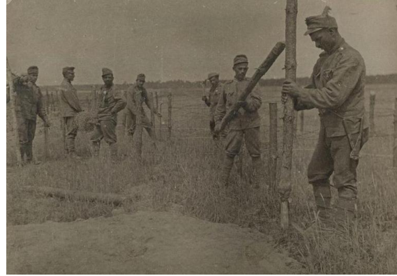
Szögesdrót-kerítés telepítése [34], [35]
