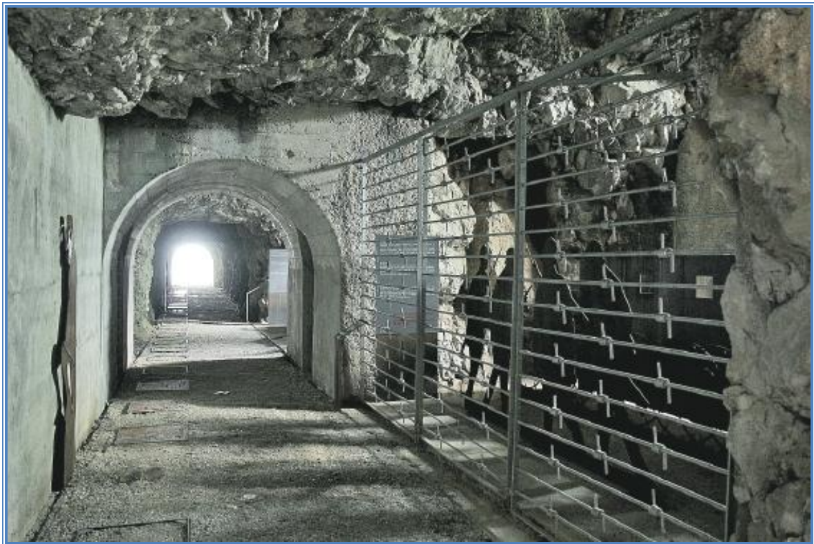
Vasbeton erődítési építmény hegyoldalban 6
