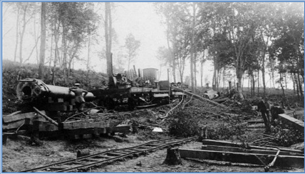
Tábori vasúti pálya építése 9
