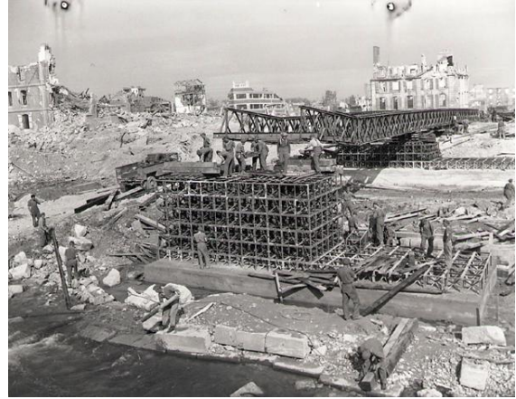
9. sz. kép Bailey speciális alátámasztáson 24
