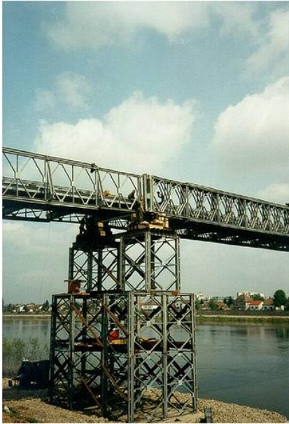
31. sz. kép A híd fix alátámasztása 56
