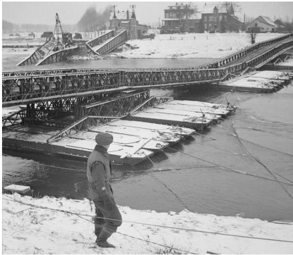
8. sz. kép Úszólajzatú Bailey híd 24
