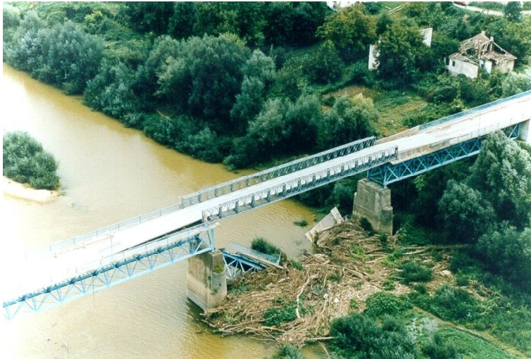
26. sz. kép A Magyar Műszaki Kontingens által épített Brcko-i híd 47
