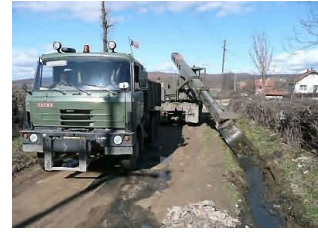
Vízvezető árok tisztítása 21
