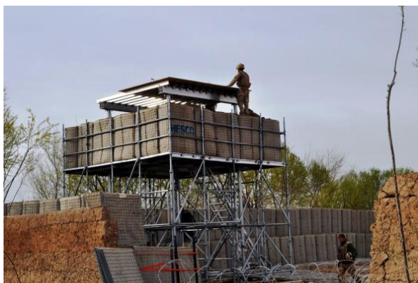
A figyelő építése 68
