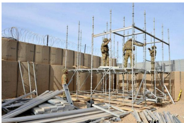
Az állványzat építése 67
