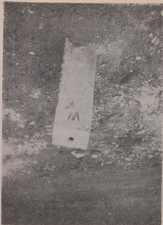
13. kép. Cementezett fúrás helyének jelzése betonhasábbal
