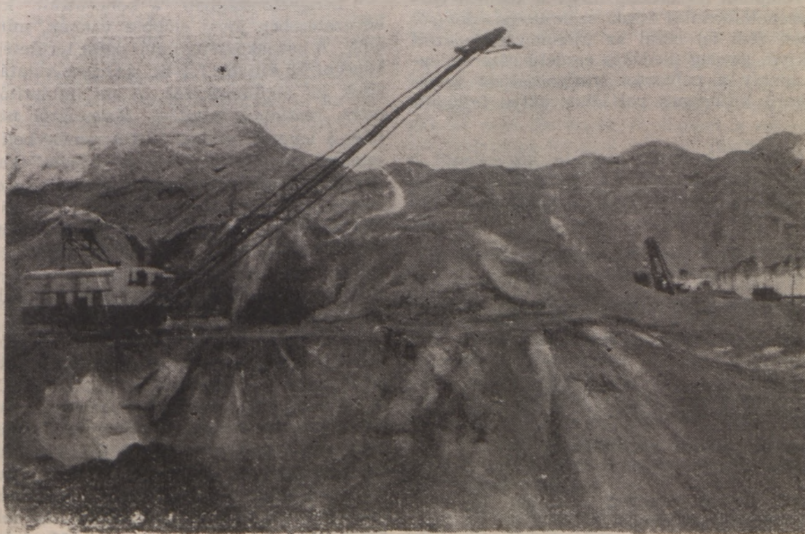
6. kép. A fedőrétegek letakarítása a babinai külfejtésben
