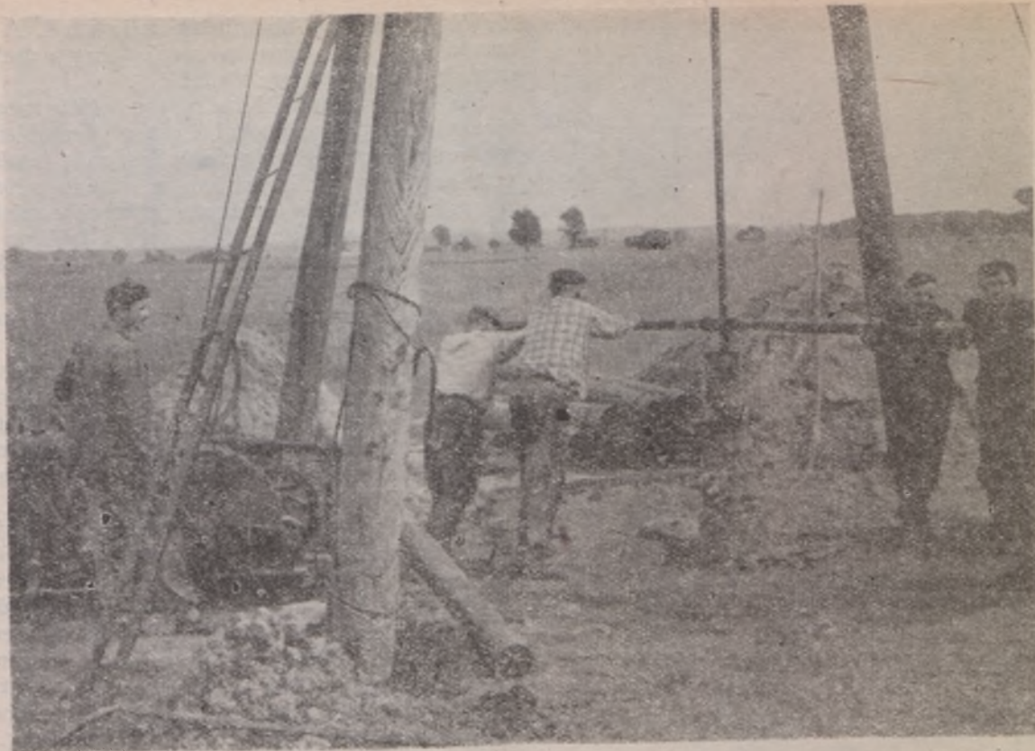
14. kép. Száraz kézi fúrás mélyítése hidrogeológiai megfigyelések céljára
