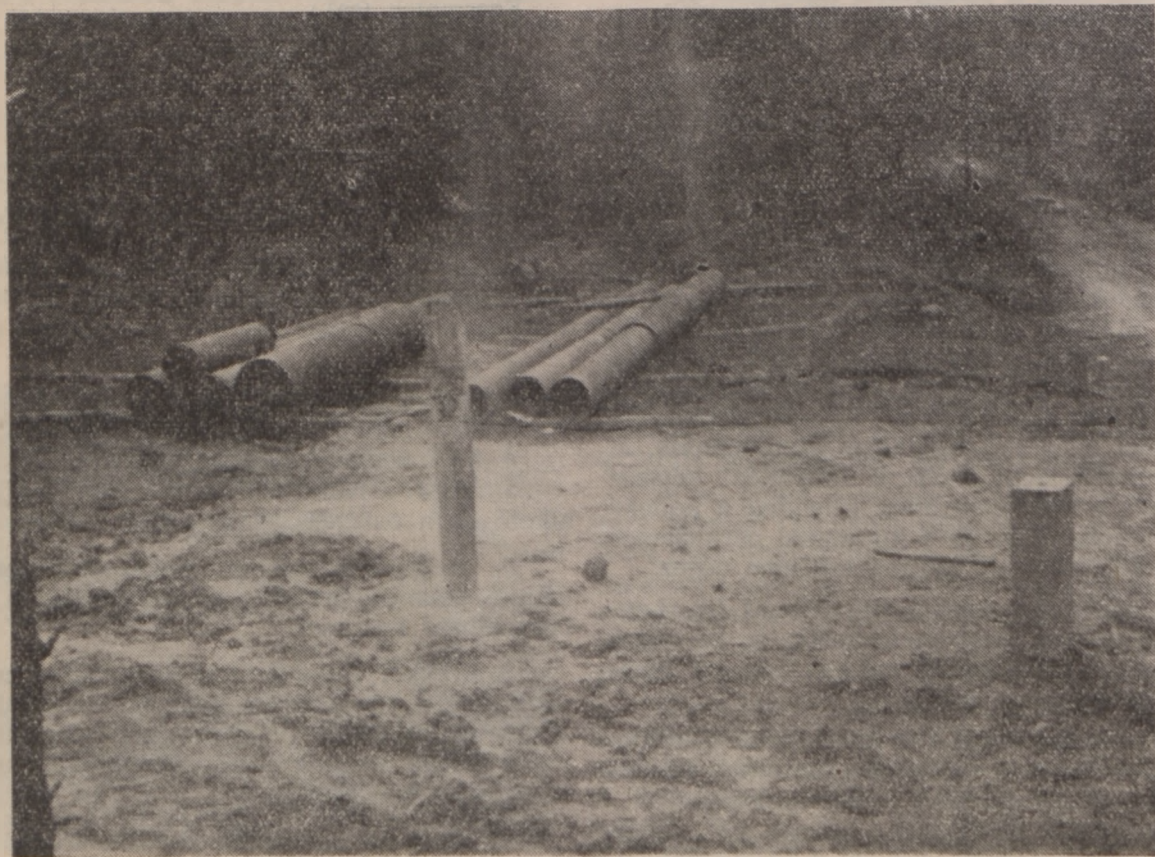
12. kép. Agyaggal eltömött fúrás helyének jelzése facövekkel
