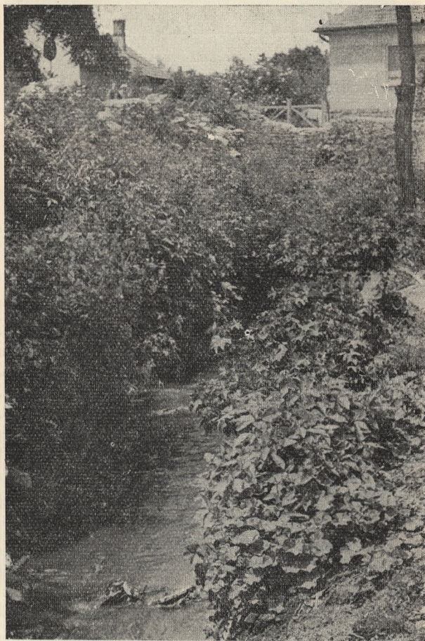
5. ábra. A Büdösárok Lehel u. alatti, növényzettel borított, elhanyagolt szakasza
