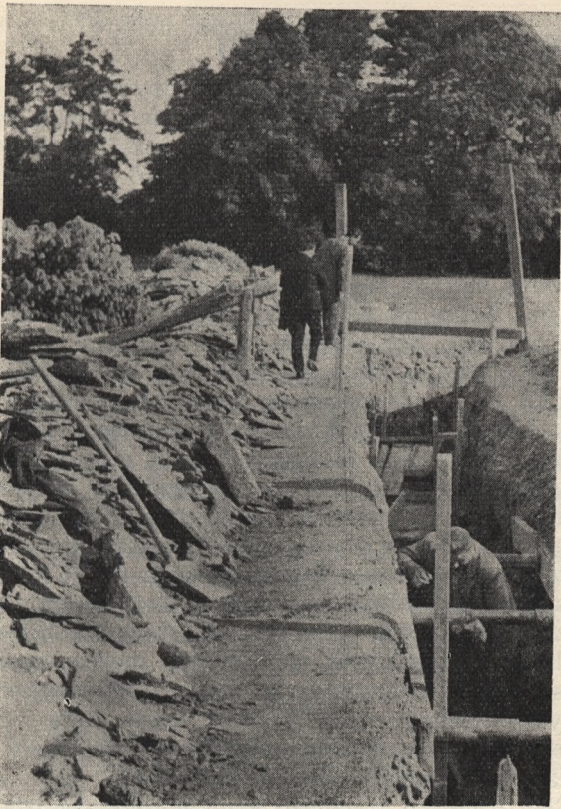
1. ábra. A Kastélykerti csatorna építése során kiemelt lemezes homokkő
