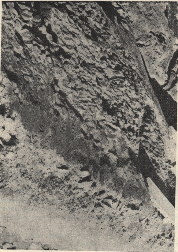
2. ábra. A Kastélykerti csatorna építésénél feltárt töredezett homokkő
