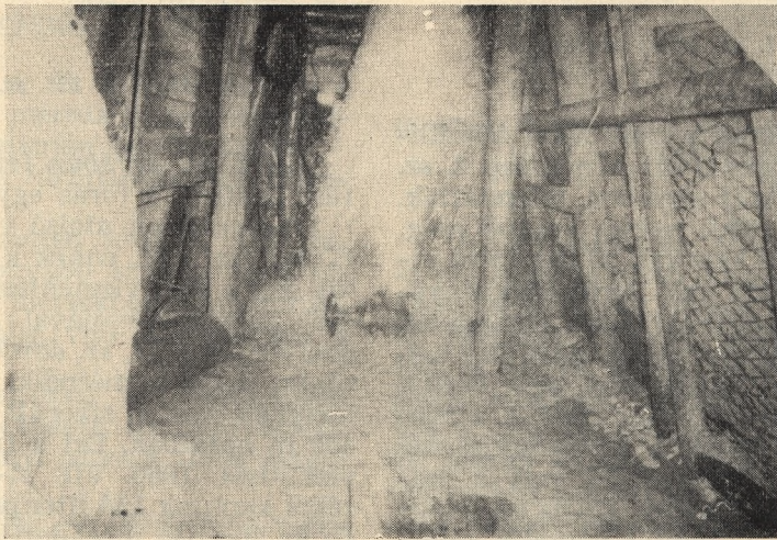
11. ábra. Fénykép a B. 215. sz. fúróllyukról. Tolózarat nyitják.
