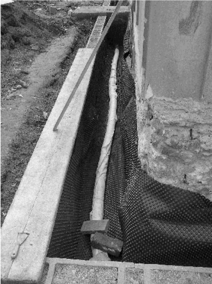
2. kép. Balf. Drénlemezzel bélelt árokba kerül a geotextiliával becsavart szivargó cső. A viszonylag olcsó műszaki megoldás a külső nedvesség jelentős részét távol tudja tartani a falazattól.
