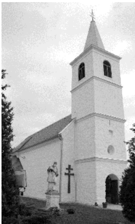
4. kép. Nemeskér, a középkori épületrész megkülönböztetése durva vakolattal.
