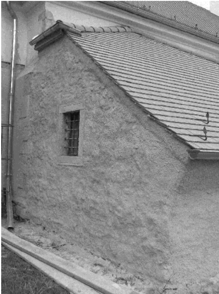
1. kép. Harka, a sekrestye durva felületű vakolata és a bádogozás nélkül, hagyományos módon kialakított tetőszegély.
