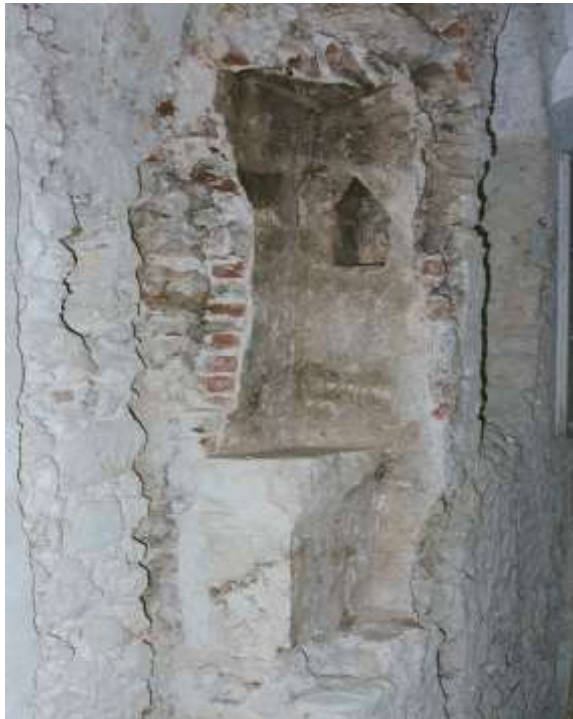
5. ábra. Sopron, ferences templom. Falifülke a legkorábbi káptalanteremben. Fotó: Nemes András
