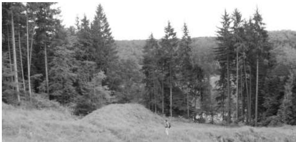
2. kép. A gerenda völgyhíd vasútvonal végpont felőli (azaz a völgyáthidalás brennbergbányai oldalán lévő) hídfője. A vasútvonal a kép bal alsó sarkából vezetett rá a hídra. A háttérben a fák között a Fehérúti tó vize látszódik, tó gátját a felhagyott vasúti töltés alkotja.
