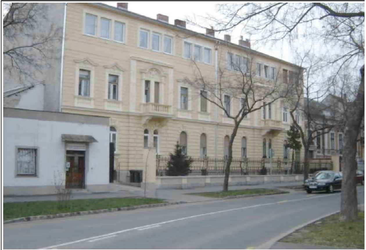
39910. kép: A Kossuth u. 7-9. épület a homlokzati felújítás nyomán kellemes benyomást kelt. A porta elbontása után visszaépíthető volna az egykori kapuoszlop és a kovácsoltvas kapuzat.
