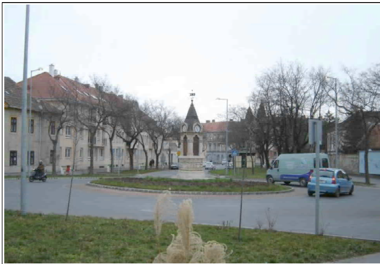
1. kép: Az óratoronynál kialakított körforgalmú csomópont az Újteleki-kapu felé
