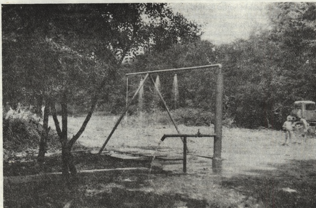
9. sz. kép. A Mád—Bomboly 290. sz. fúrás kettős kútfejének képe. A zuhanyrózsák által eszközölt megcsapolás állandó fürdési, a tolózáras kifolyó pedig egyéb vízkivételi lehetőségeket biztosít.
