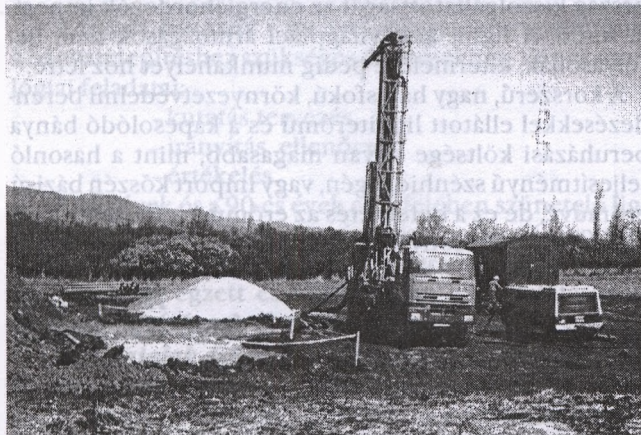
Határvédő kút furása SB-3 fúróberendezéssel
