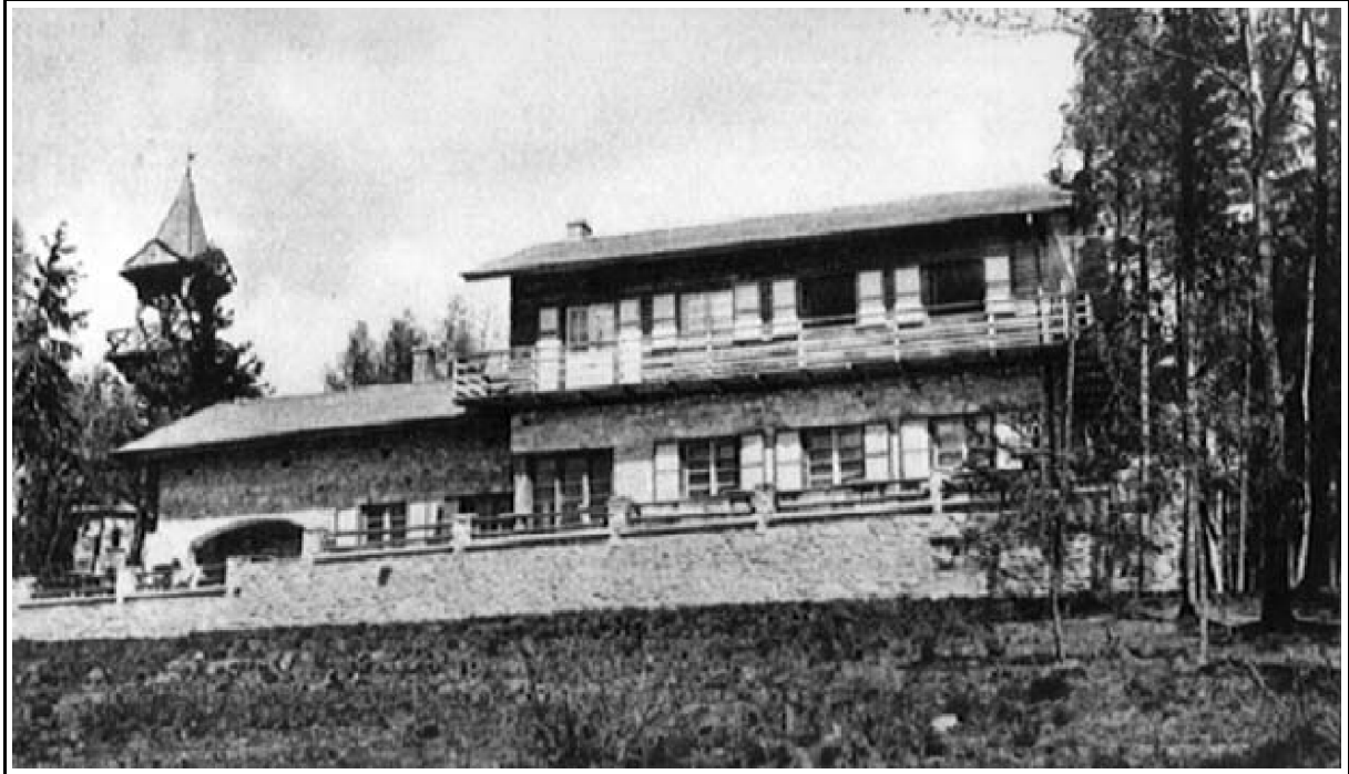
9. A Muck-kilátó Schiller János soproni építőmester alkotása, előterében a Winkler Oszkár építész tervei szerint 1938-ban épült István menedékház áll.
