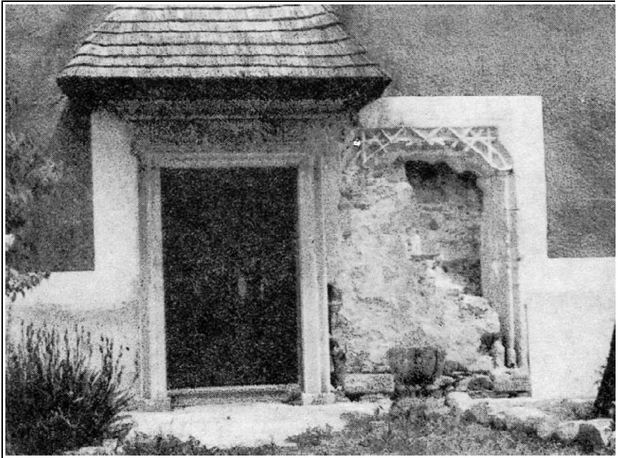
6. A várkápolna bejárata és a feltárt későgótikus ajtókeret
