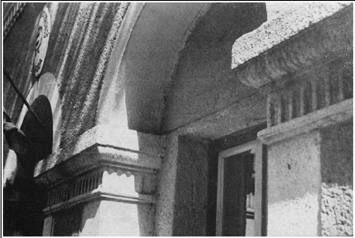
5. Rozália út 3: Megmaradt építészeti részletek a nyugati homlokzaton
