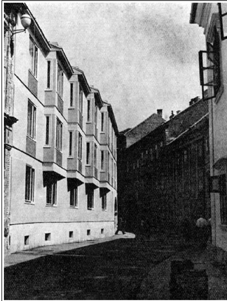
10. kép: A kétemeletes lakóház lépcsősen tagolt utcai homlokzatát a szabálytalan beépítési vonal indokolja (Szt. György u. 18. sz.)
