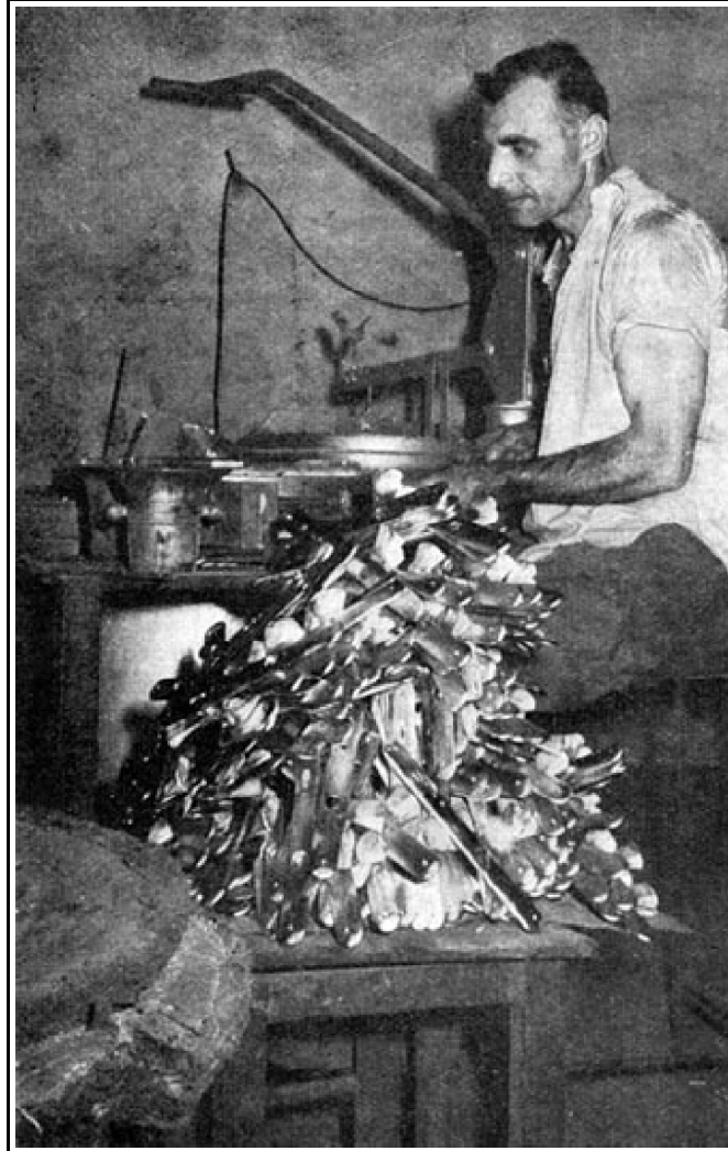
Ajtókilincs-cím kokilla öntése elektromos fűtésű kemencében. 1967
