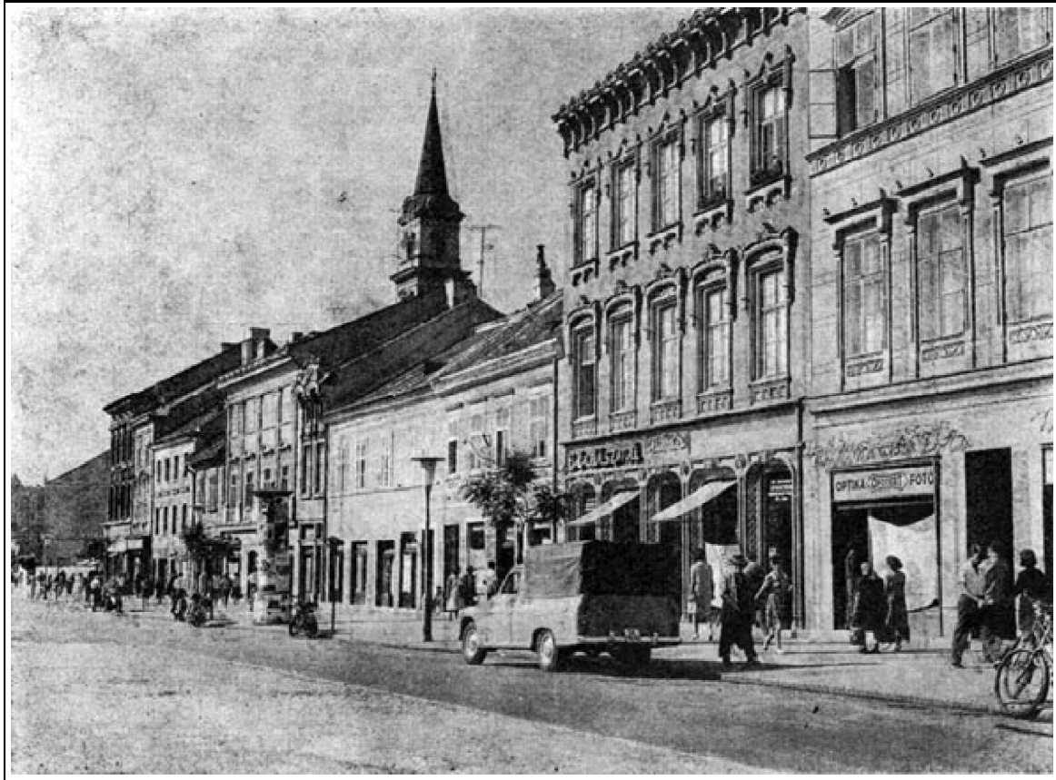
A Lenin körút felújított homlokzatai
