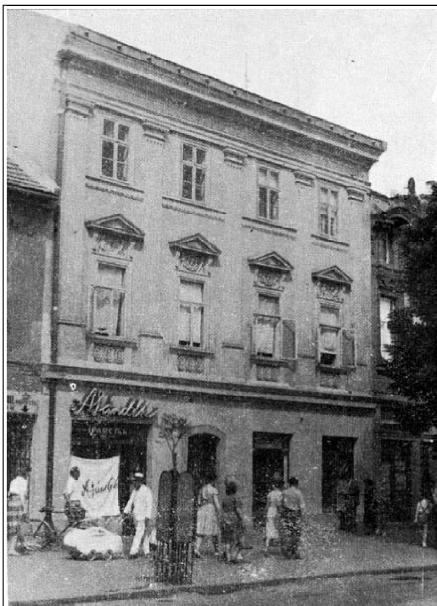
Lenin körút 88. A felújítás után
