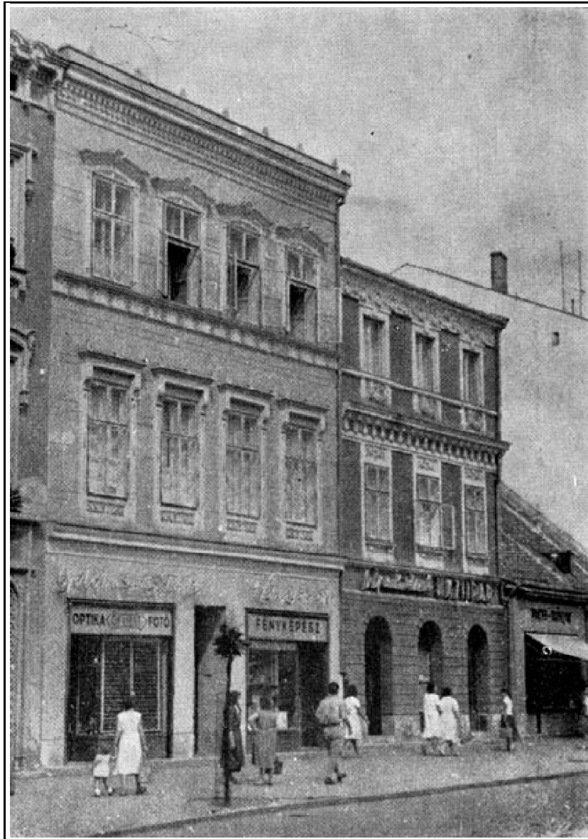
Lenin körút 70., 72. A felújítás után
