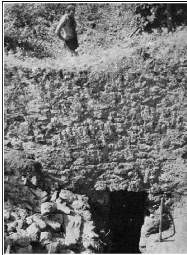
2. A mészégető kibontott tűzelőnyílása belülről
