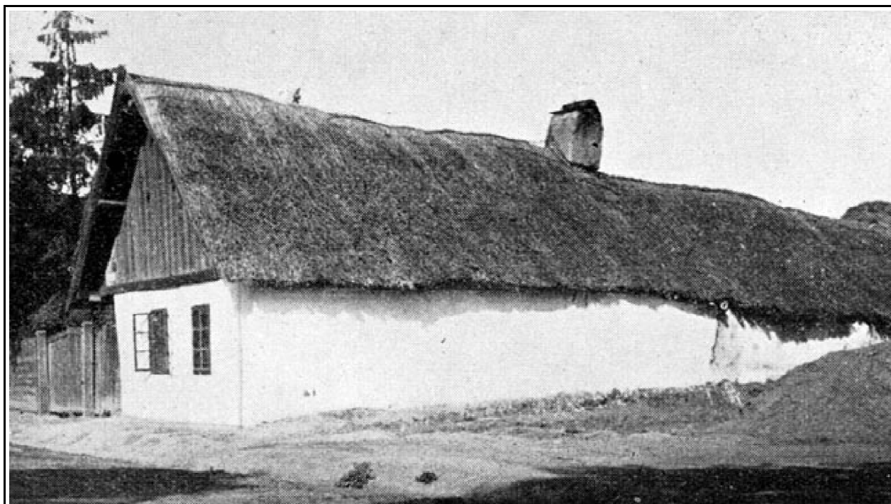
5. erősen megújított régi ház sövénykéménnyel, mely alatt a fal gerendával megtámasztott. Kisfalud. (Csatkai E. felvétele)
