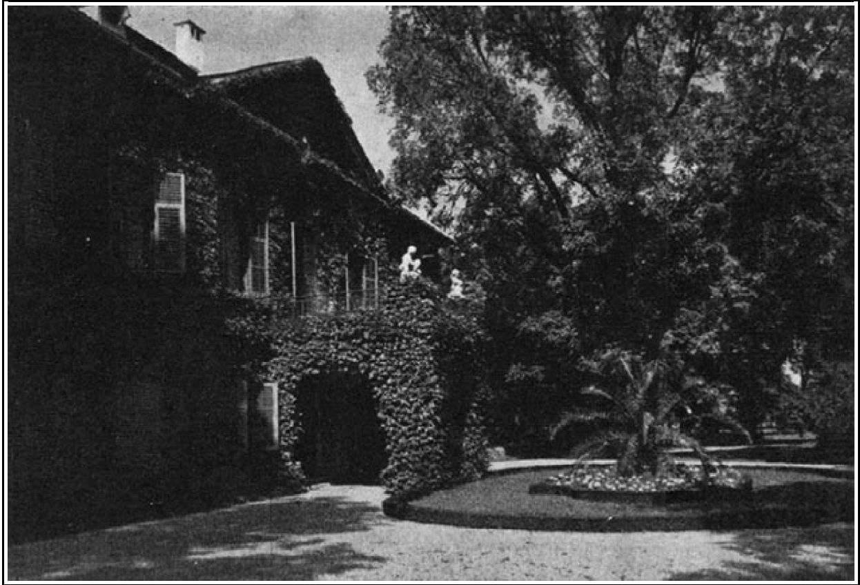
3. kép. A röjtői kastély. Főhomlokzat.
