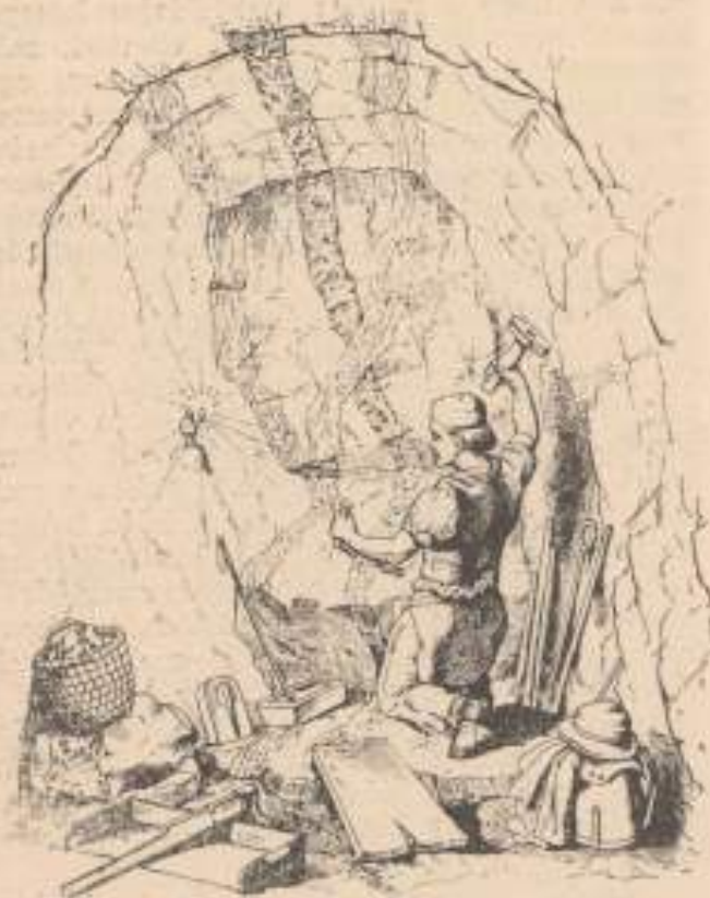
2. sz. ábra. Fúrólyuk készítése az 1880-as években. (Eduard Heuchler: Des Bergmanns Lebenslauf című munkájából. Dr. phil. Hanns Freydank féle 1940. évi kiadás. Blatt 13.)
