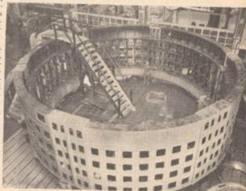
A Siemens-típusú 100.000 kVa víz-turbína áramfejlesztő külső burkolata.
