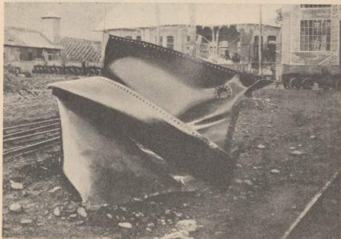
3. kép. A légtartánynak 50 m. távolságra röpült övlemeze. (Ugyanaz, mint a 2. képen.)
