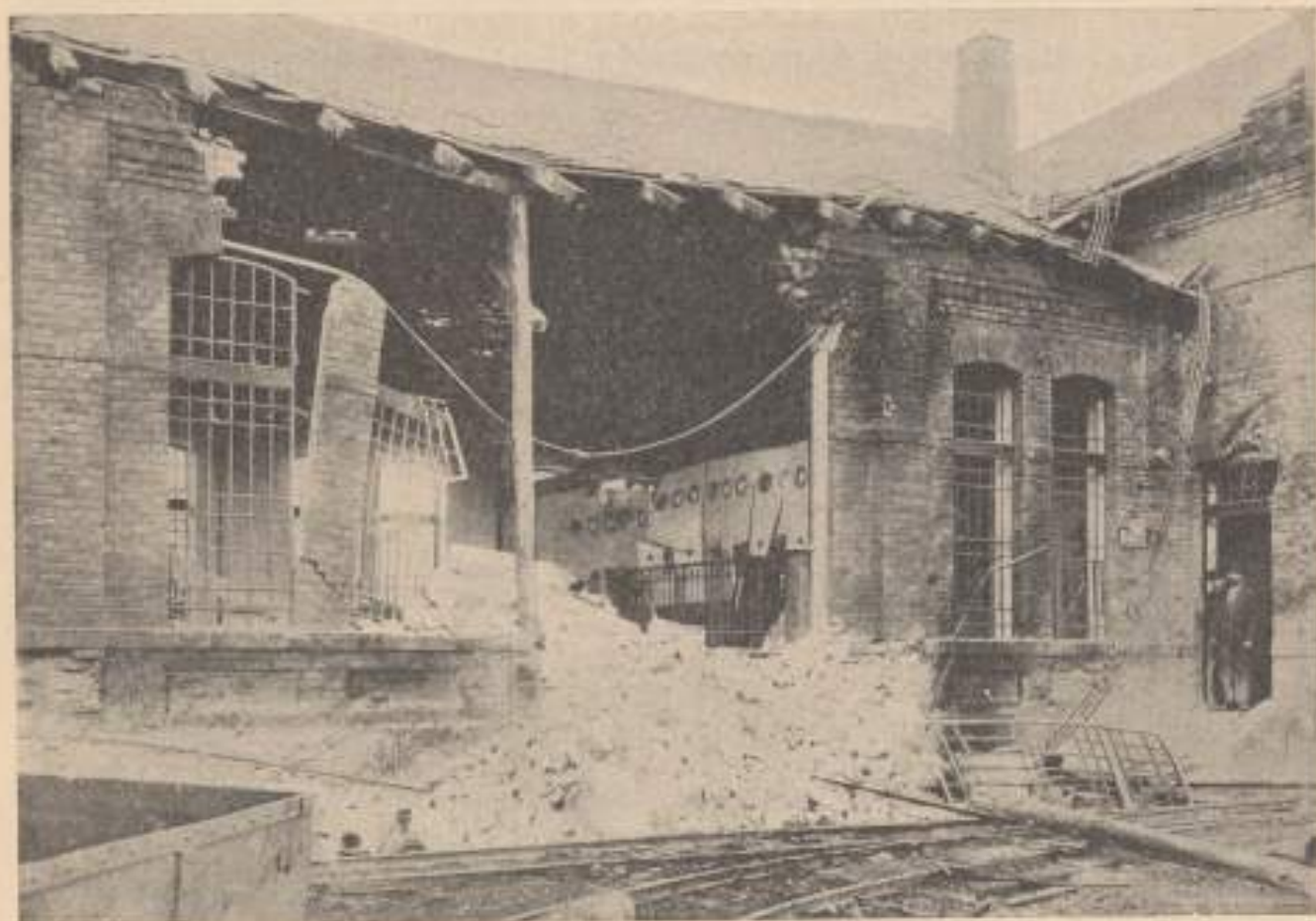
1. kép. A kompresszor-gépháznak a légnyomás folytán bedőlt fala. (A légtartány a törmelék helyén állott.)
