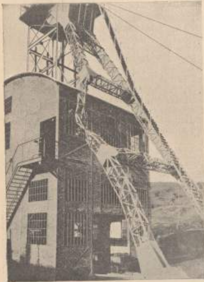
6. kép. A 4. és 5. képen látható övlemez által szétszakított aknatorony-oszlop.
