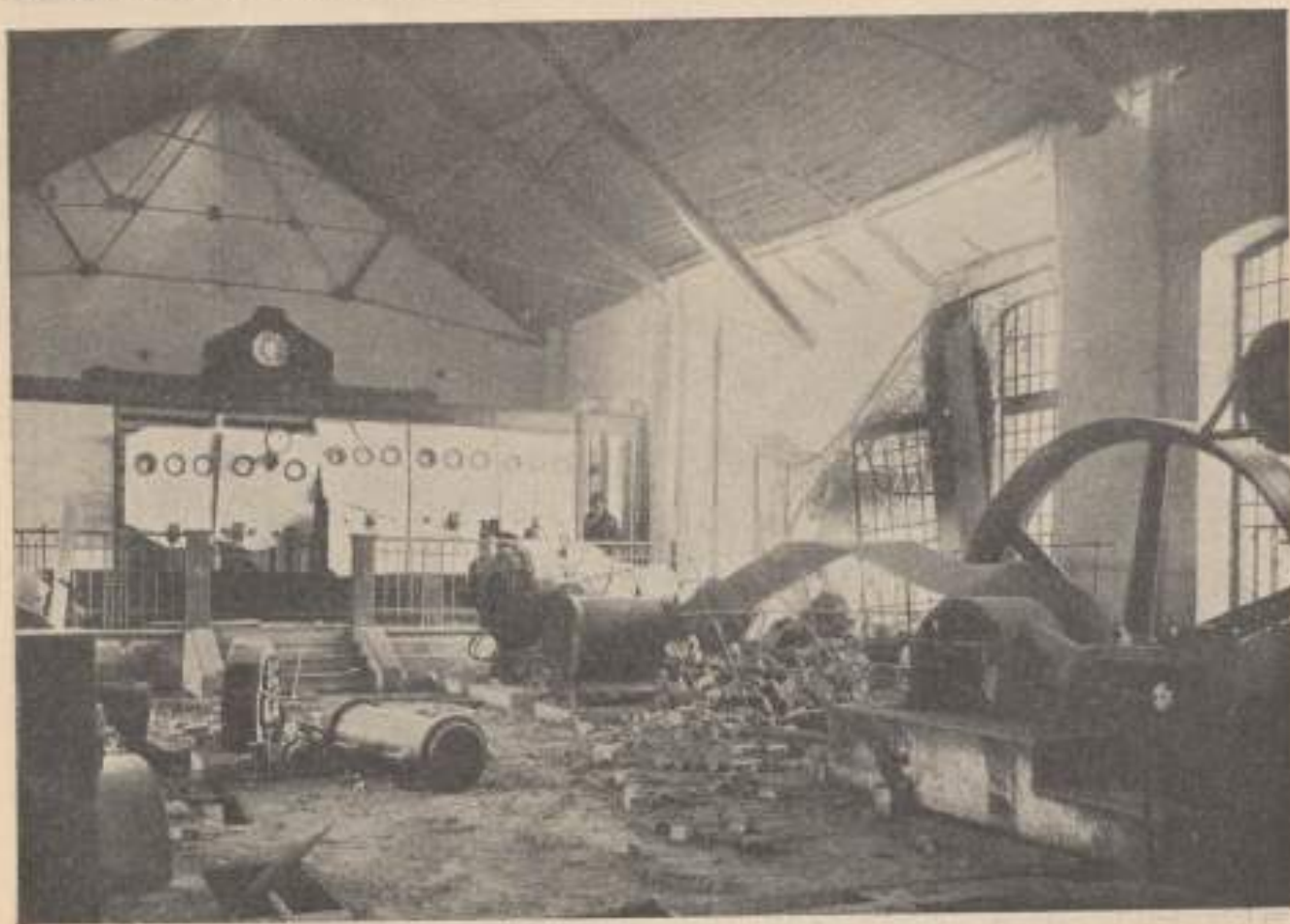
11. kép. A kompresszor-gépház belseje a robbanás után. A kép jobb oldalán a kompresszor s az összedőlt fal látható.
