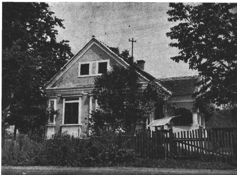
5. ábra. 1895-ben épült lakóház, udvari homlokzatán kiugró „filagóriával”. Szalafő, Alsó-szer.
