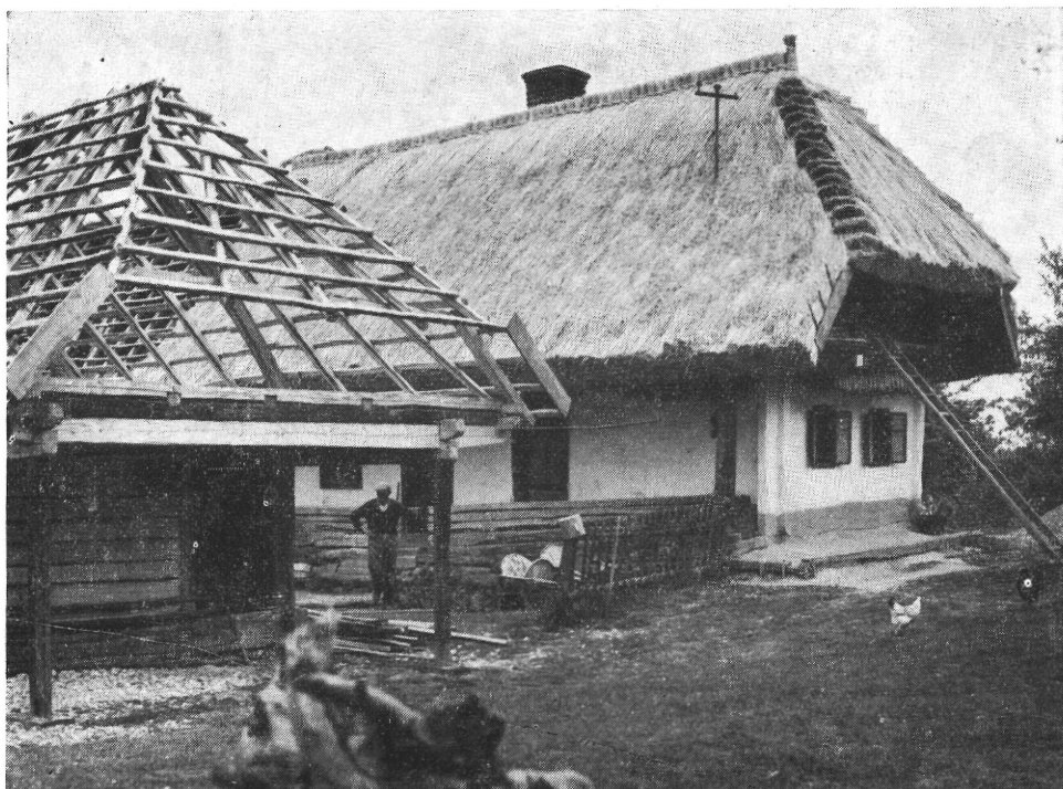
11. ábra. Zsoldos Antal Pityer szeri kerített házának restaurálása 1968-ban az OMF által. A képen jól megfigyelhető a ház tetőszerkezete Balassa M. Iván felvétele. F.215.153
