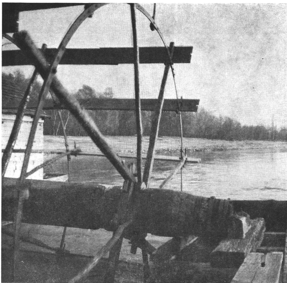
5. ábra. Uszód. Hajómalom. Részlet. Vízikerék — hajtókerék. (17. fényképfelvétel.)
