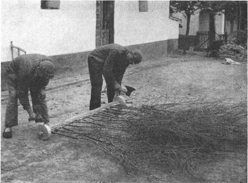
2. ábra. Kerekes borona. A kerekek beékelése. Várong 1963. Abb. 2 — Radegge. Verkeilung der Räder. Várong 1963.
