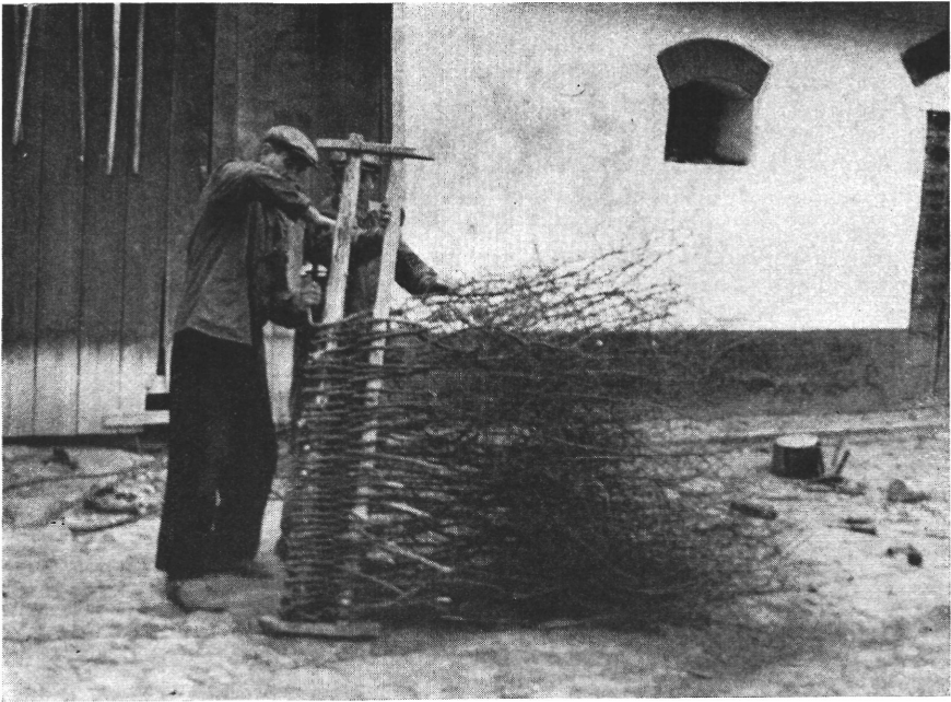
6. ábra. A kökényágak szorosra verése. Várong 1963. Abb. 6 — Zusammenpressen der Schlehenäste. Várong 1963.
