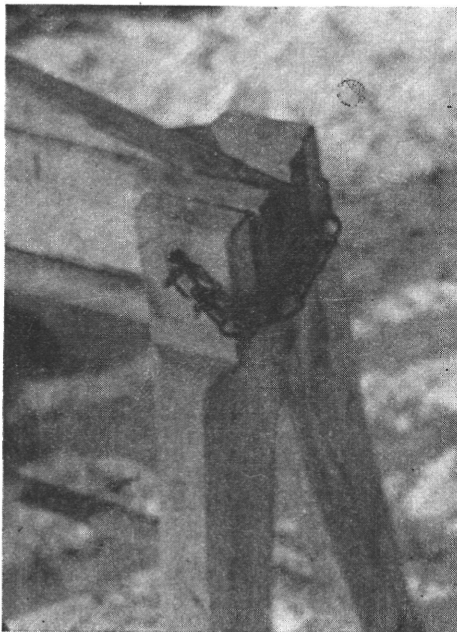
13. ábra. A lábazatba „becsotolt” tilódeszákák. Dunaremete, Győr m.
