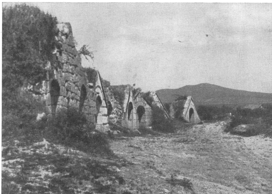
21. ábra. Pinceház nélküli lyukpincék (Hercegkút, Borsod-Abauj-Zemplén m.)
