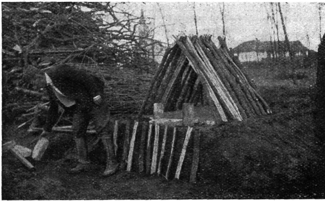
3. ábra. Dinnyés gunyhó sütökemencéje épülőben. U. o.
