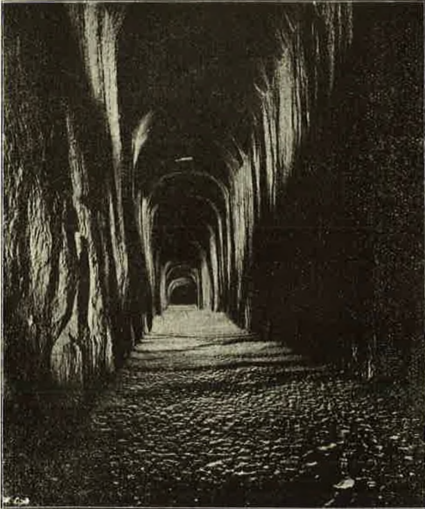
Figur 4. Der in Trachyttuff getriebene 1 Km lange Tunnel Grotta della Pace zwischen Cumae und dem Averno-See (Aufnahme von Dr. MORITZ v. PÁLFFY).
