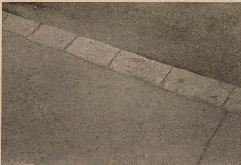
5. ábra. A kép közepén jobboldalt a sárga andezit fellevelezett egyes részei le is váltak. Mellette balra az üde Csódi-hegyi kék andezitban változás nem látszik. A kőzethasábok járda szegélynek vannak beépítve. Kicsinyítés : 1 : 10
