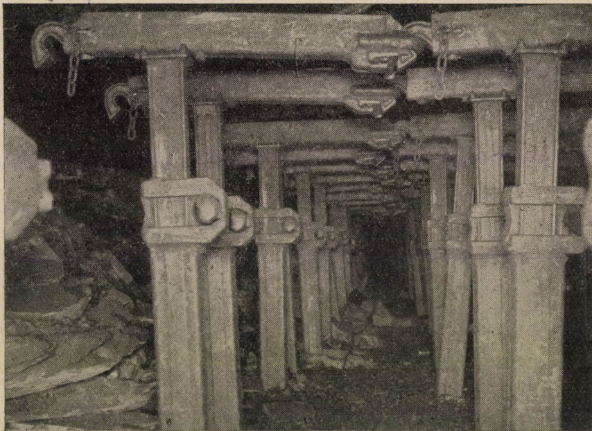
34. ábra. Acéltámokkal és csuklós süvegekkel biztosított frontfejtésnek az omlasztási vonal melletti része
