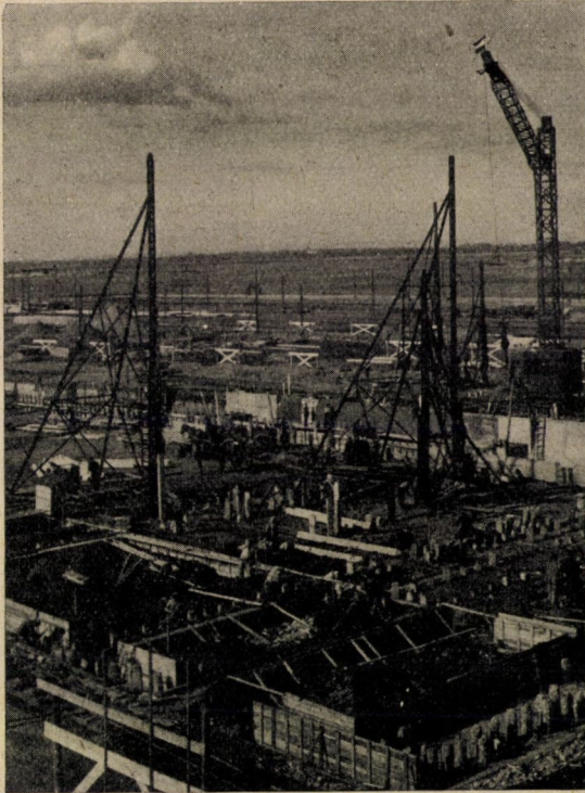
15. ábra. A tiszapalkonyai erőmű cölöpalapozásának látképe
