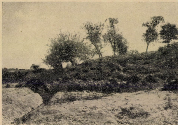
15. ábra. Mánfa—komlói út. A talajkúszásból származó földtömeg elöntötte az útiárkot
