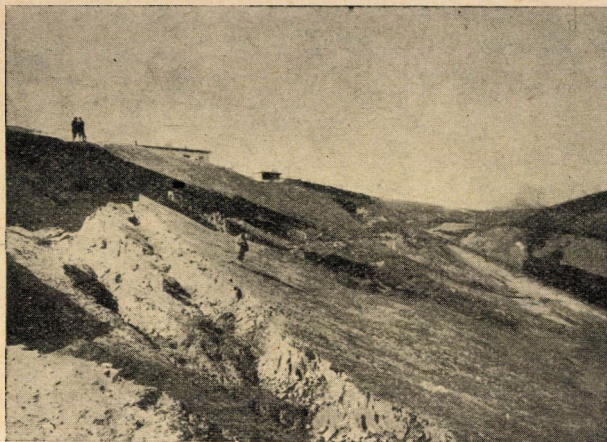
10. ábra. Csúszás a váchartyáni mélybevágás részüinél
