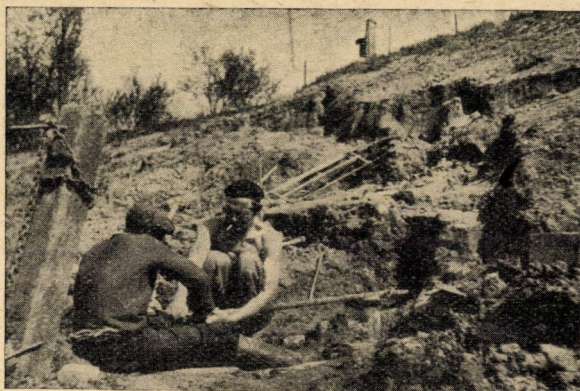
16. ábra. Vízszintes fúrások végzése kézi fúróberendezéssel.
