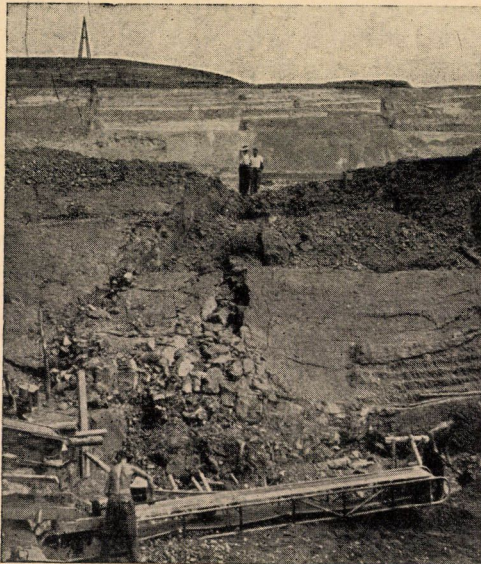
9. ábra. Rézsűrogyás mozaikszerkezetű agyagtalajban
