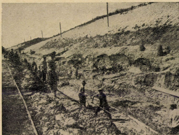
13. ábra. Az alapi bevágás építése. A rézsüből kilépő talajvíz lekagylózásokat okoz
