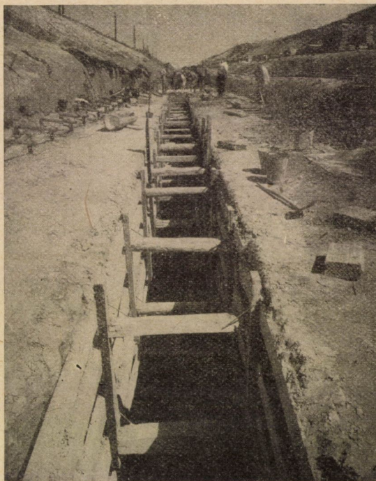
9. ábra. Végleges tengelyszivárgó készítése vákuumkutas víztelenítés védelme alatt
