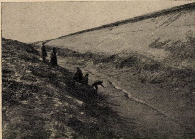
12. ábra. Az alapi bevágás iszapos finom homok talaja, a talajvízszin elérésekor folyóssá vált
