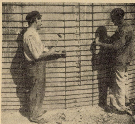
9. ábra. A kúpfelületre tekereszt huzalok feszítése
