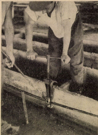
2. ábra. GKT födém elem feszítése
