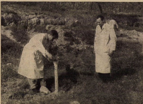
8. ábra. Izotóp betáplálása a fúrólukba
