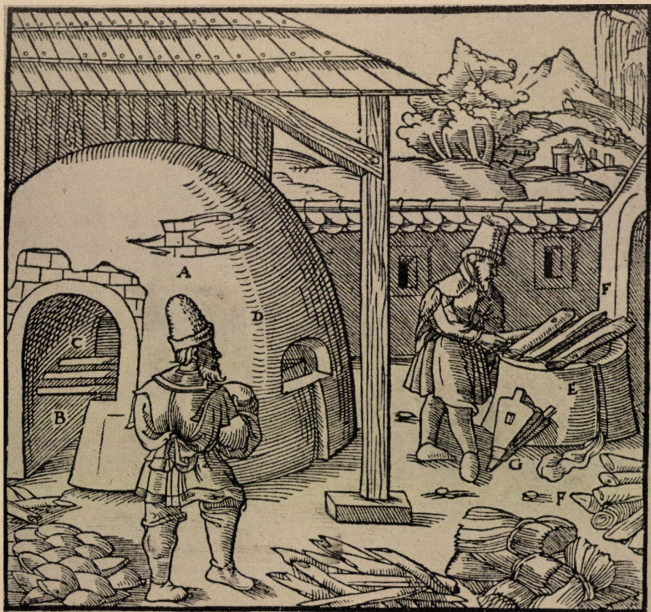
6. ábra Magyar üzökemence. A) kemence, B) csurgó, C) tűzrostély D) nyílás, melyen át lehúzták az ólomlétet, E) kemence, földél nélkül, F) vastag fahasábok, G) fűjtató
