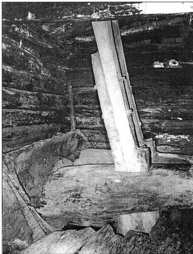
15. kép. Lengőkalapácsos kalló (posztóványoló). Nérahalmos (Prigor CS), 1999.
