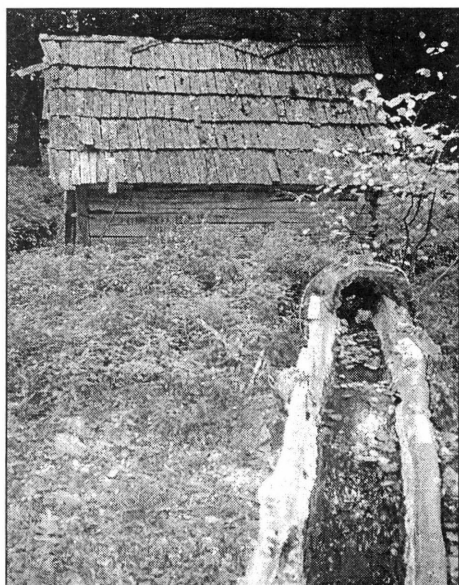
5. kép. Archaikus kanalas malom, odvas fatörzsből készült lajjal. Liubcova (CS), 2000.
