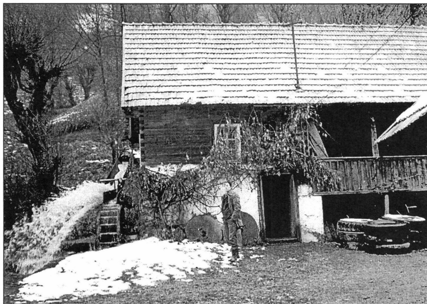
8. kép. Felülcsapott vízimalom. Valea Bistrei (AB), 1999.
