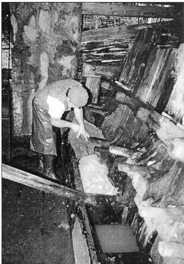
14. kép. Sillye Lőrinc kallómolnár jármos posztóványolójában a szövetet a botok alá engedi. Lövete (HR), 1999.
