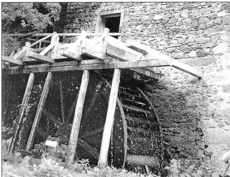
9. kép. Hátulcsapott vízkerékkel működtetett, modern vízimalom. Lövété (HR), 1997.
