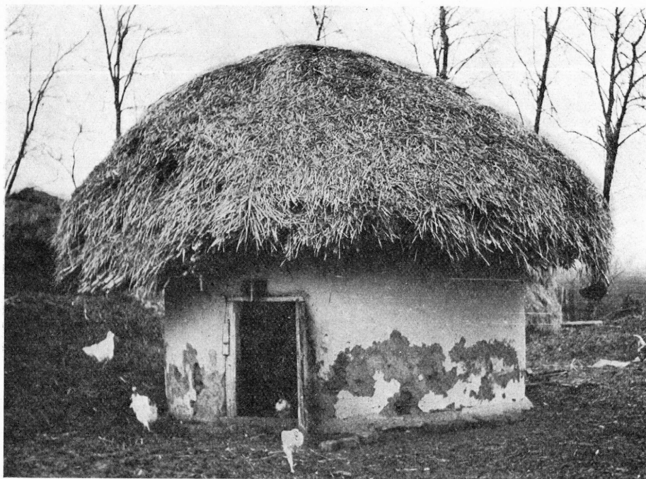
5. kép. Egyszerűbb ereszkiképzés. Kerek tyúkól Mészáros Antal tanyáján Cserebökény
