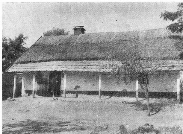
10. kép. Hajnal u. 60. sz. (korábban Legelőszél): toldott ereszű szoba-konyhás (szabadkéményes ház) (1967)
