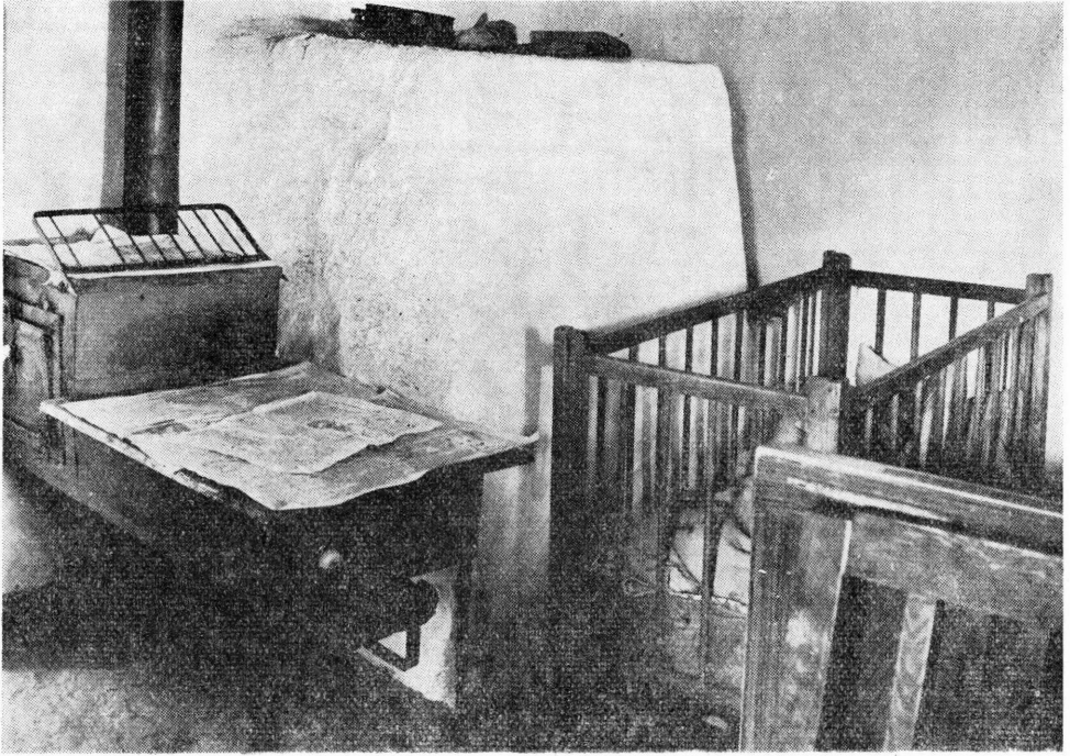
16. kép. Szobai kívülfűtős álló sárkemenca. Mellette hordozható vaslemez takaréktűzhely. Bana, Komárom megye. Foto: FILEP Antal, 1960.
