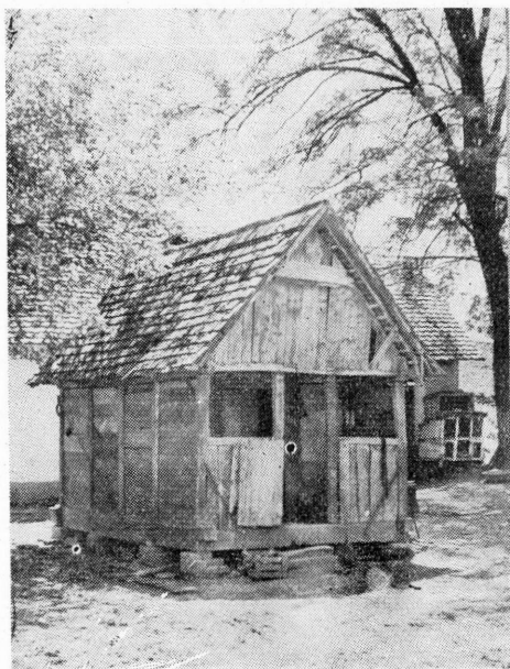
6. kép. Gerendavázis gabonás deszkázott tornáccal Szalántán. Foto: FÜZES Endre
