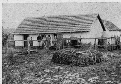
32. Vályogból épített, új komplex melléképület, melyben lomskamra, istálló, baromfiól és két disznóól nyert elhelyezést
