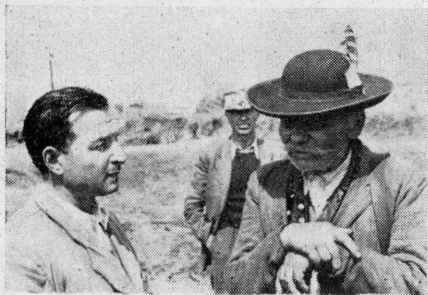
17. Az építkezés részleteinek megbeszélése
