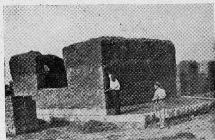
29. Kész, rakott fal; az építésvezető méri a jól látható, három ízben rakott rétegek magasságát
