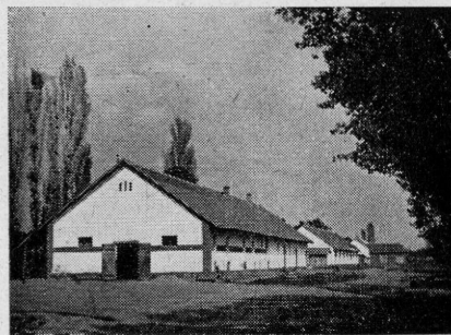
17. Cselédlakások, istállók, Iszap-puszta. Épültek 1892-ben. Ma Állami Gazdaság: irodák, lakások, istállók, műhelyek
