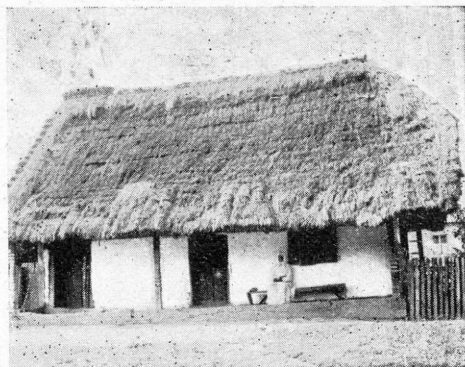
23. ábra. Kétosztatú magyar ház, előtte a pitar. A szoba és konyha (balra) ajtaja külön nyílik a pitarra. Alaprajzát l. 26. ll. b. ábra. Drávafok. Gunda B. felv.
