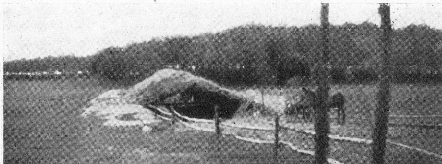
26. ábra. Akol földbemélyített birkaszínnel. Peszéradacs.
