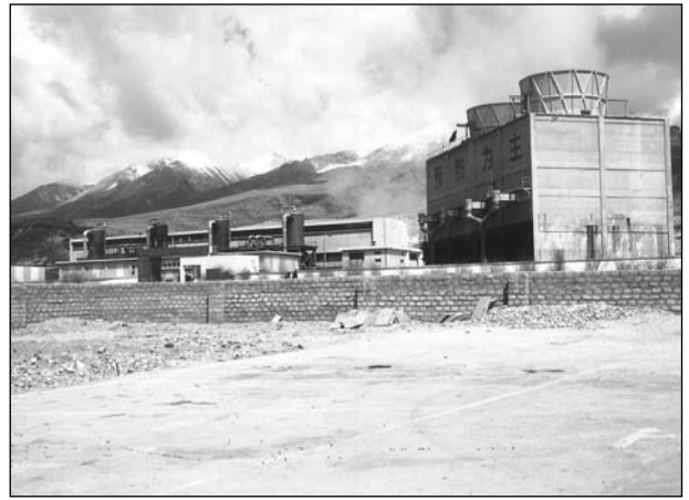
4. kép. Az üzemelő geotermikus erőmű
