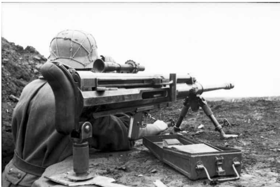
17. ábra. A M. Kir. Honvédségben 1936-ban rendszeresítették az 1936 M. Solothurn 20 milliméteres páncéltörő nehézpuskát. A fotón jól látható az optika
