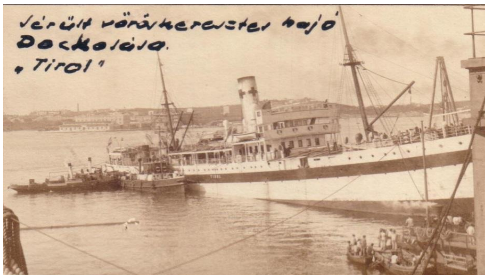
4. ábra. Az osztrák TIROL kórházhajó 1916. április 16-án Durazzo (ma: Durrës) előtt futott aknára. Veszteség 34 halott volt, a hajó part-ra futott, ott javították, később elvontatták Cattaróba és kijavították (fotó: Bánsági Andor szívességéből)
